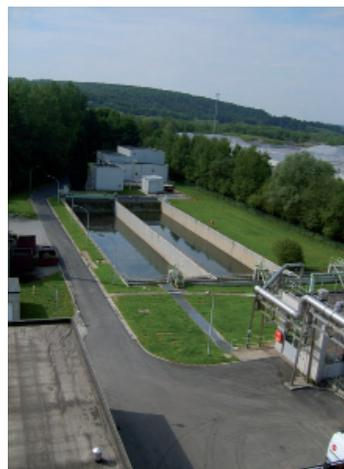
Vue des bassins d'orage en 1er plan ainsi que des nouvelles unités de réception des gadoues et des curures d'avaloirs en arrière plan
