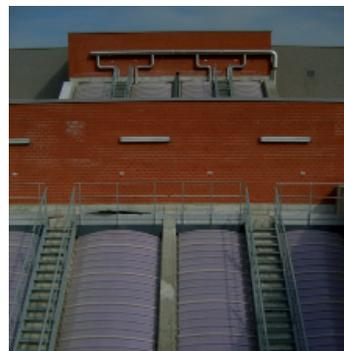
Relevage des eaux usées par vis d'Archimède capotées
