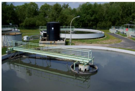
Décanteurs primaires et stockage de chlorure ferrique en milieu de plan (STEP de Roselies)
