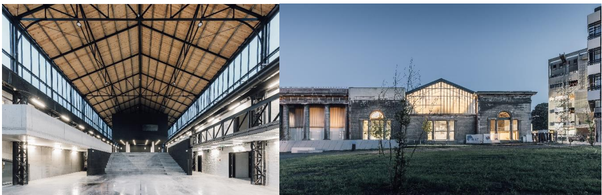
Bâtiment « Maçonnerie » - Campus UCharleroi
