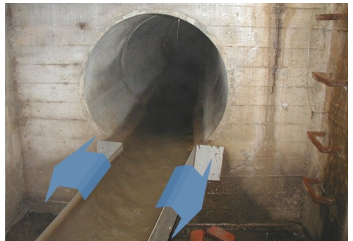
Déversoir d'orage à poutre
