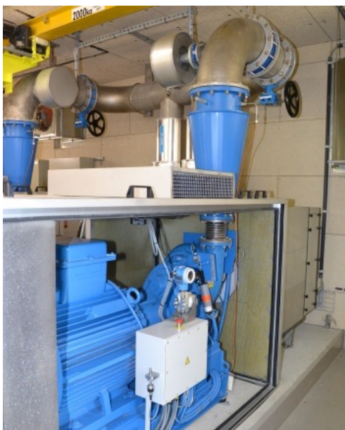
Turbosoufflante de la STEP de Thuin
