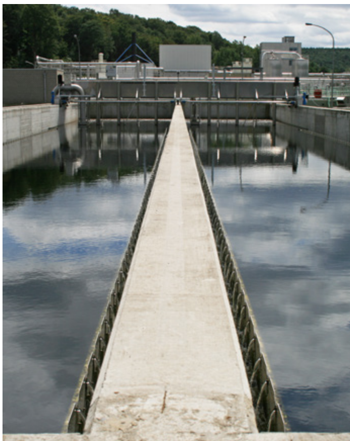
Clarificateur de la STEP de Roselies
