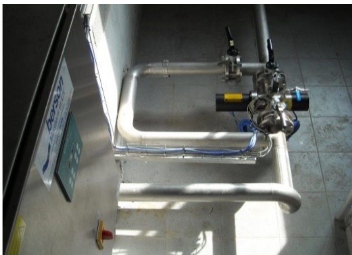
Lampe UV de désinfection des eaux épurées de la STEP d'Erpion
