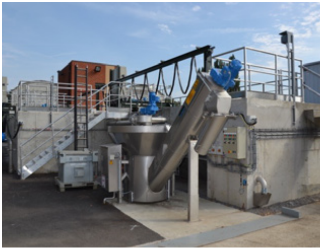
Unité de dessablage et déshuilage de la STEP de Roux
