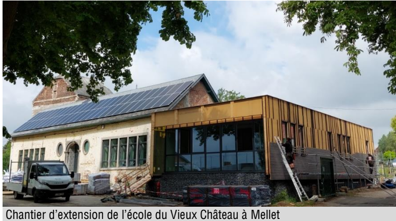
Chantier d'extension de l'école du Vieux Château à Mellet
