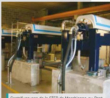
Centrifugeuses de la STEP de Marchienne-au-Pont
