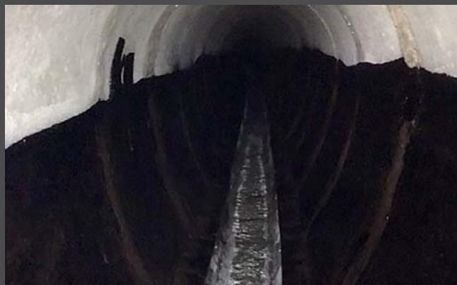
Après analyse des défauts et des différentes techniques de réhabilitation existantes, en concertation avec le bureau SECO, le choix s'est porté sur la pose de coques en polyester renforcé de fibres de verre PRV. Ce matériau a l'avantage d'offrir une bonne résistance aux produits chimiques et à l'abrasion, en plus d'être assez léger ce qui facilite la manutention des coques à l'intérieur du collecteur.
