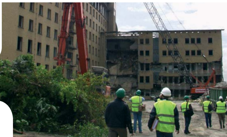
Ce 14 septembre, les engins de chantier de l'entrepreneur CASTAGNETTI ont terminé la démolition des bâtiments de l'ancien hôpital de Jumet, en venant à bout des derniers vestiges.
