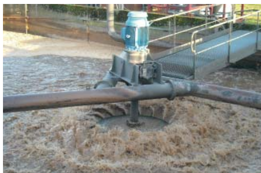
Aérateur de surface de la STEP de Baileux
