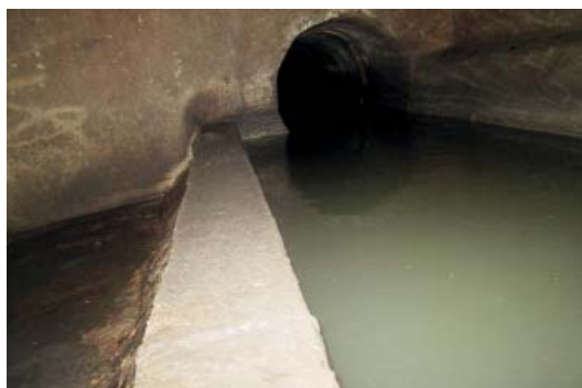
Déversoir d'orage à seuil de débordement
