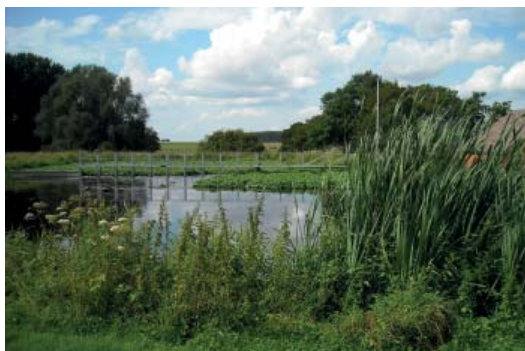
Lagune aérée de la STEP de Grand Reng
