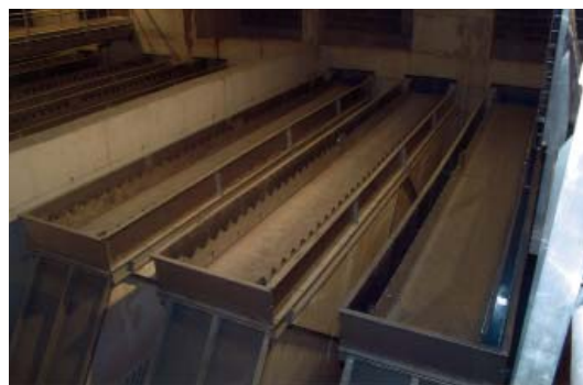
Décantation primaire lamellaire (vide) de la STEP de Montignies-sur-Sambre
