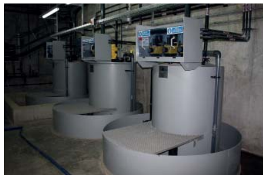
Stockage de produits chimiques à la STEP de Viesville
