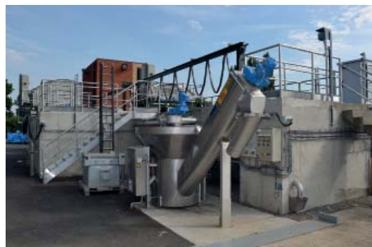
Unité de dessablage et déshuilage de la STEP de Roux
