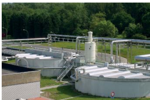
Épaisseurs de la STEP de Roselies
