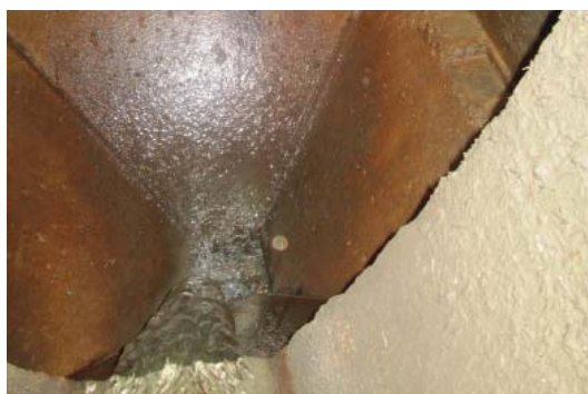
Déversoir d'orage à orifice
