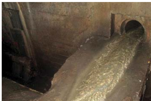
Déversoir d'orage à poutre
