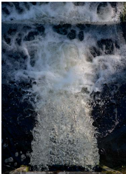
Déversement des eaux épurées de la STEP de Solre-sur-Sambre
