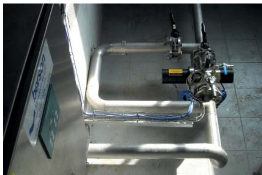
Lampe UV de désinfection des eaux épurées de la STEP d'Erpion
