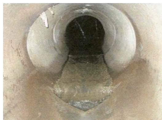
Déversoir d'orage à orifice
