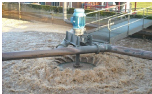
Aérateur de surface de la STEP de Baileux
