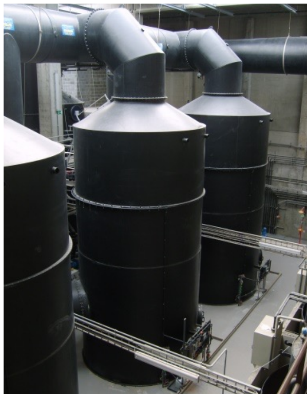
Tours de lavage chimique à la STEP de Marchienne-au-Pont
