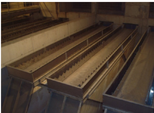
Décantation primaire lamellaire (vide) de la STEP de Montignies- sur-Sambre
