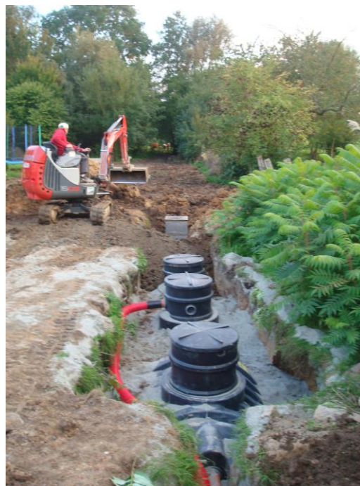
Pose d'une unité d'épuration individuelle de 5 équivalents-habitants dans la commune de Lobbes
