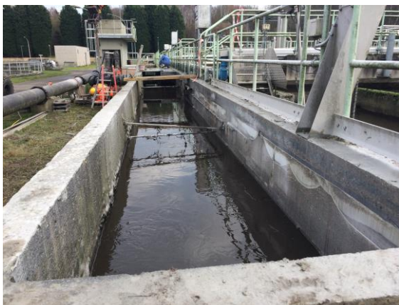
Chenal de sortie réhabilité des bassins d'aération de la station d'épuration de Roselies
