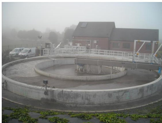
Station d'épuration de Fleurjoux
