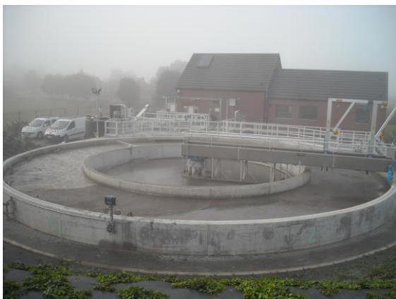
Station d'épuration de Fleurjoux
