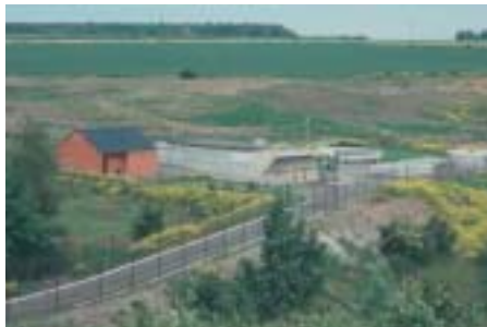
Station d'épuration de Souvret (Bassin versant du Moulin de Souvret): 4.000 EH
