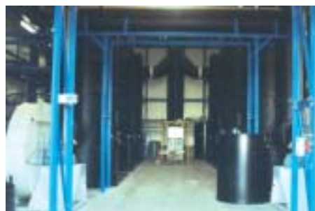
Vue intérieure du bâtiment de désodorisation
