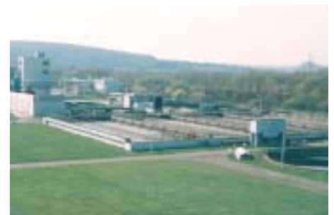
Station d'épuration de Roselies: 212.000 EH
