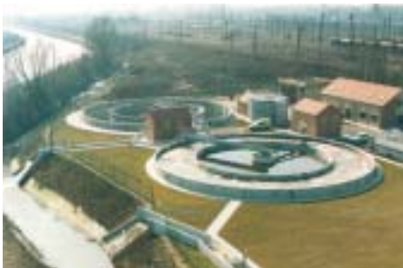
Station d'épuration de Roux-Canal: 24.000 EH
